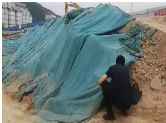
临时覆盖措施 (2020.3.26)
