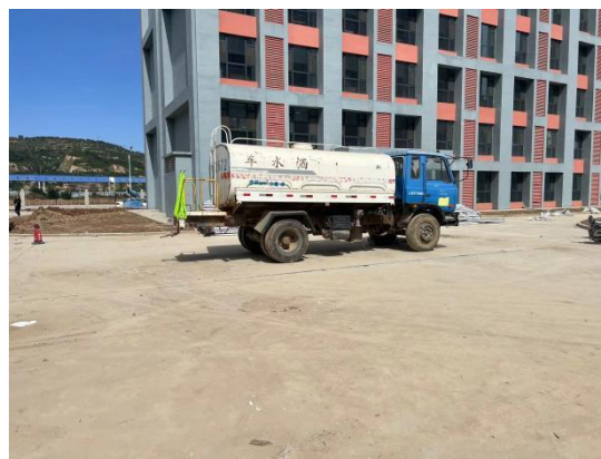
临时洒水措施 (2022.1.6)
